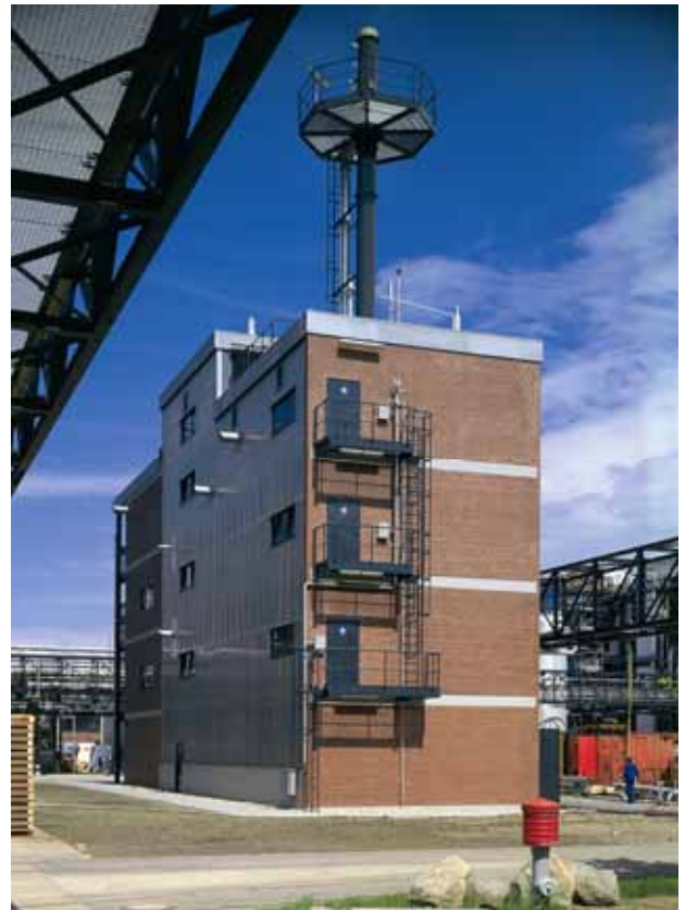
Die Thermische Abluftreinigungsanlage
